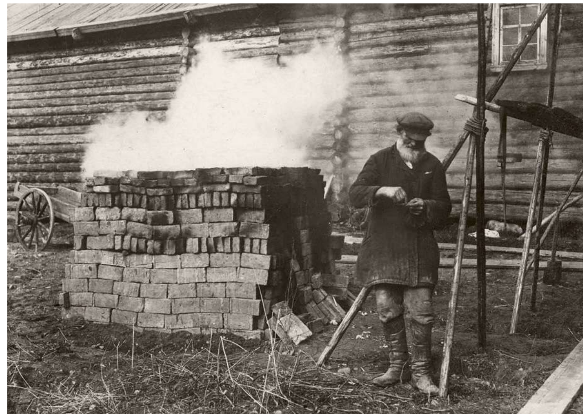
Обжигание самодельного кирпича для постройки русской печи. 1929 г.
